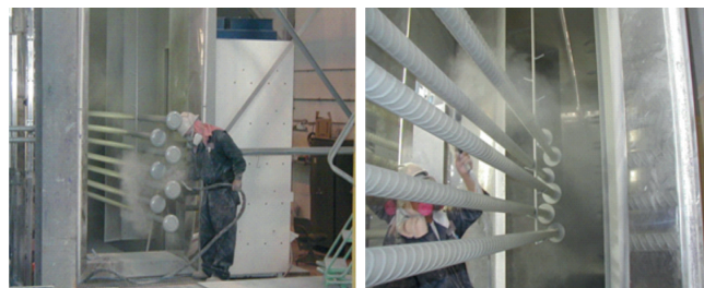
Rys. 1. Nakładanie powłok epoksydowych na stal zbrojeniową [M1]
