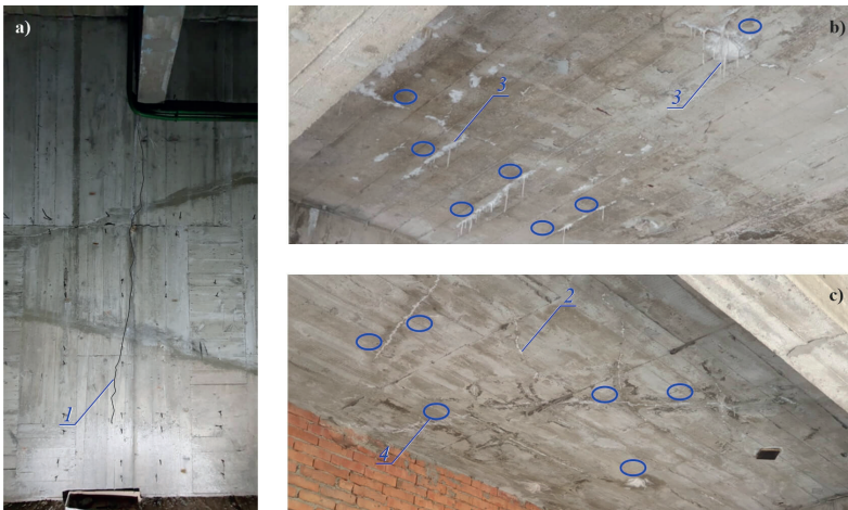
Rys. 2. Uszkodzenia żelbetonowych elementów konstrukcji budynku: a) ścian, b) c) płyt balkonowych; 1 – pionowa rysa na ścianie pod belką, 2 – rysa skośna na płycie, 3 – rysa z wykrystalizowanym w formie stalaktytów węglanem wapnia, 4 – miejsca wykonanych pomiarów sklerometrycznych w sąsiedztwie rys
